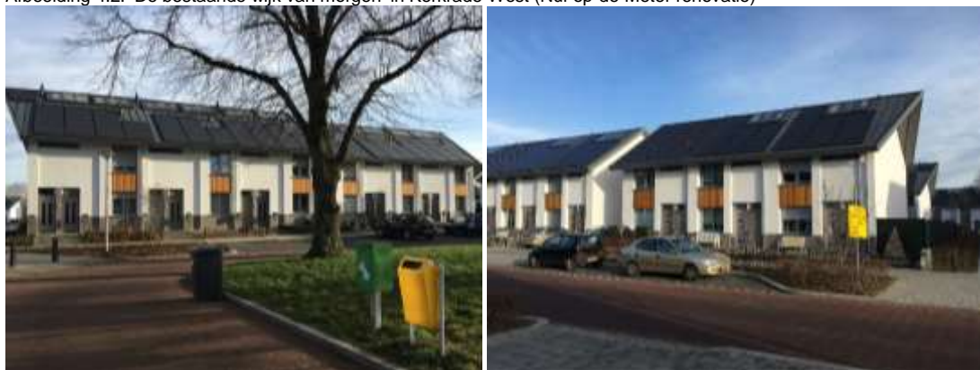
Afbeelding 4.2: 'De bestaande wijk van morgen' in Kerkrade-West (Nul-op-de-Meter renovatie)
